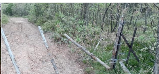
Paso valla abierta
